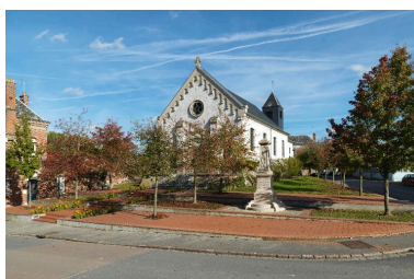
Vue générale de trois-quarts. Phot. Thierry Lefébure IVR22_20128001014NUC2A
