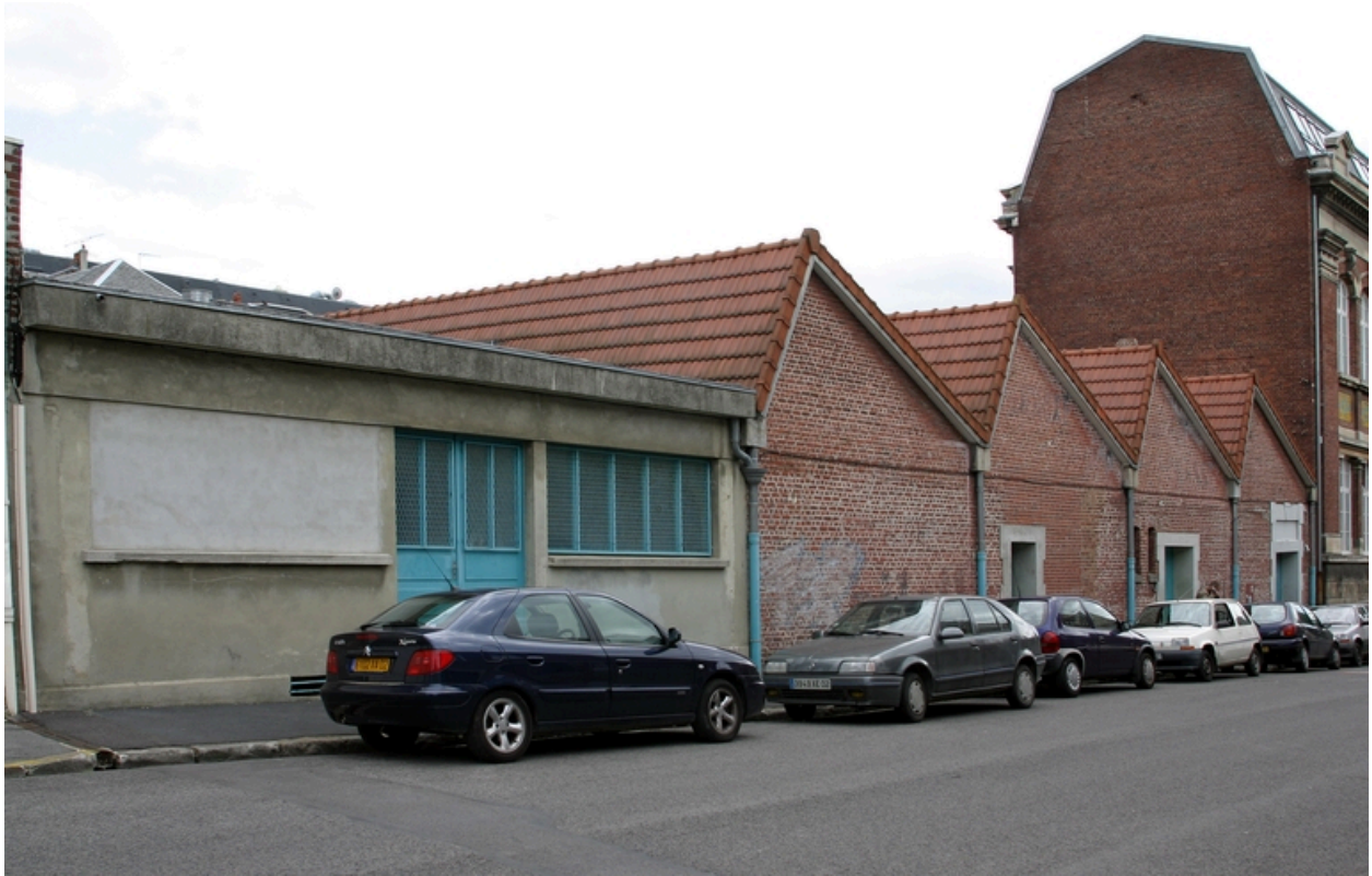
Vue des ateliers, rue Emmeré.
