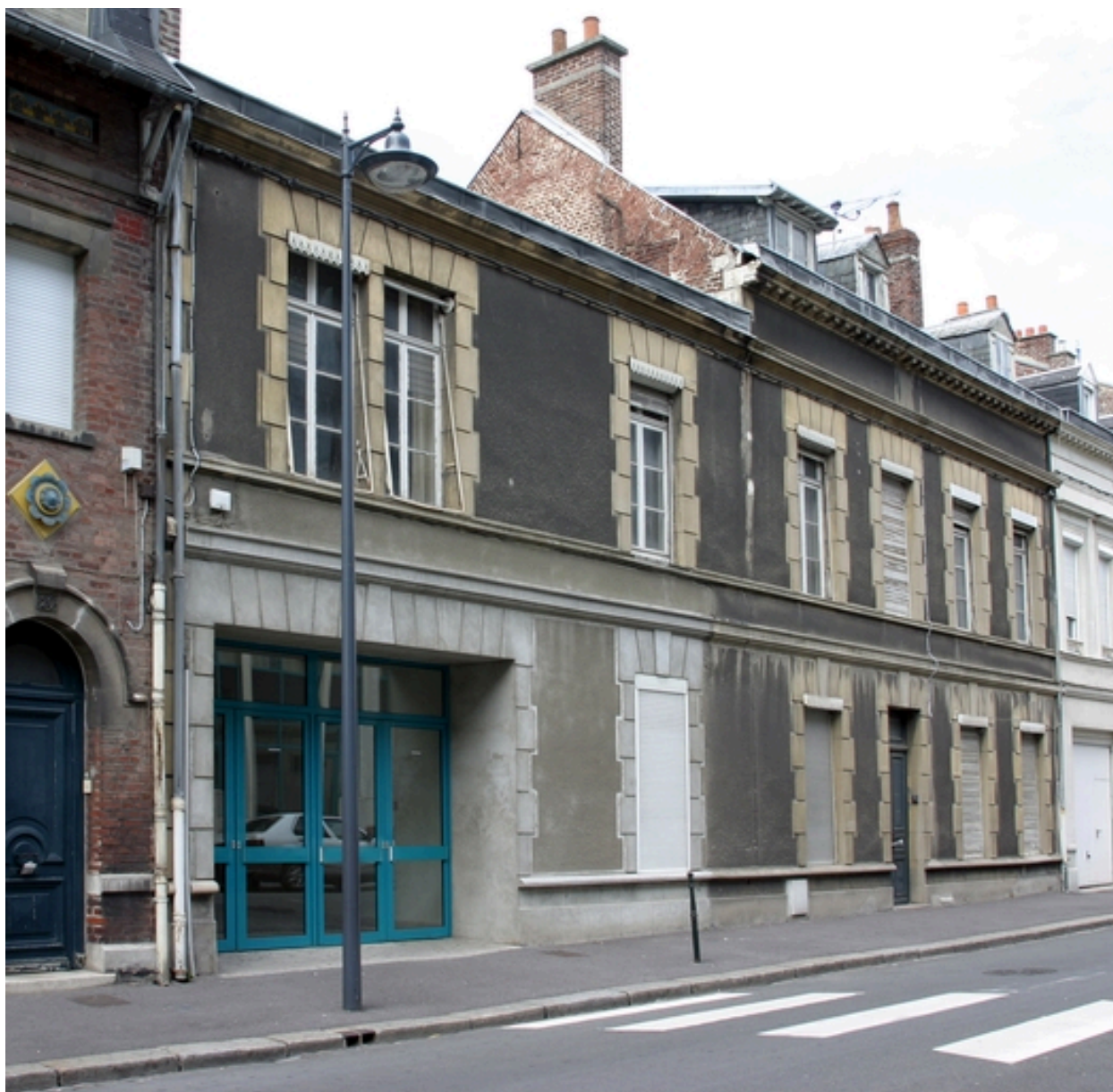
Vue des bureaux, rue Antoine-Lecuyer.
