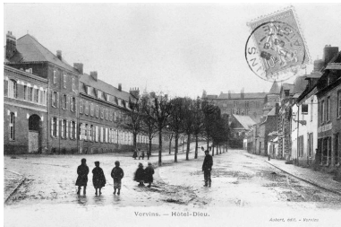
Vue d'ensemble de l'hôtel-Dieu (1903). Phot. Jumel Laurent IVR22_19970201121ZB
