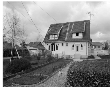
Module d'habitation, maisons jumelées sises aux 68-70 avenue du Général-Leclerc, élévations antérieures. Phot. Olivier Marlard IVR31_19945900279V
