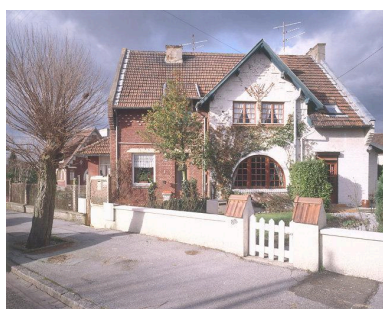
Module d'habitation, maisons jumelées sises aux 88-90 avenue du Général-Leclerc, élévations antérieures. Phot. Olivier Marlard IVR31_19945900464VA
