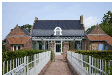
Vue du bâtiment depuis le pont. Phot. Delphine Volto Jourdan IVR32_20235901153NUCA
