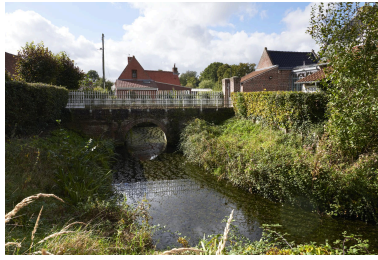
Pont de brique enjambant le fossé en eau. Phot. Delphine Volto Jourdan IVR32_20255900903NUCA
