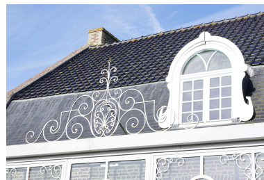
Détail de la lucarne principale et des ferronneries de la verrière. Phot. Delphine Volto Jourdan IVR32_20255900795NUCA
