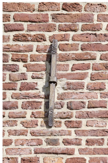
Fer d'ancrage droit avec gravures. Phot. Delphine Volto Jourdan IVR32_20255900904NUCA
