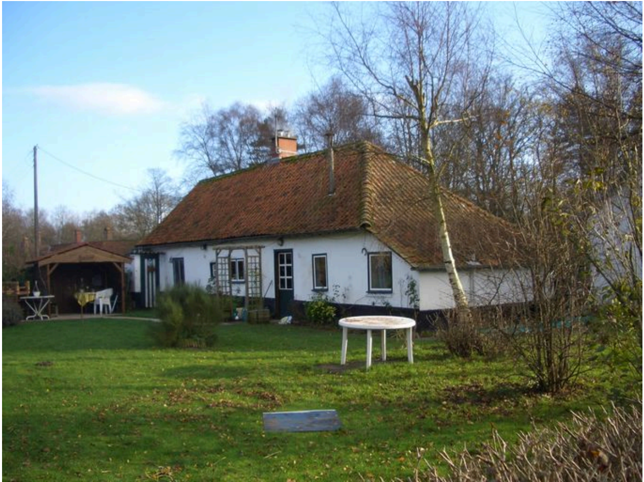
Vue postérieure du logis.
