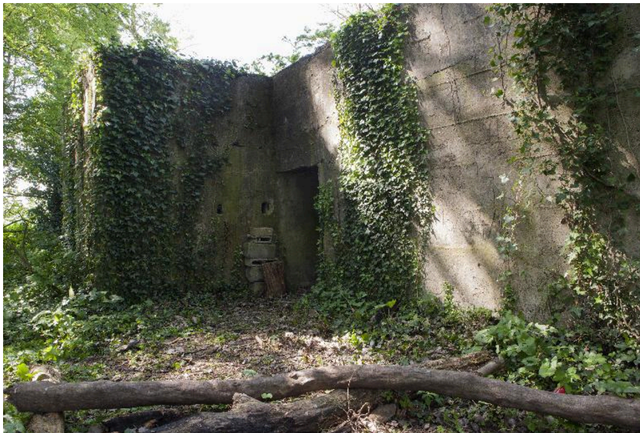
Coursière de tir (dont on voit les deux créneaux de fusillade) et entrée ouest
