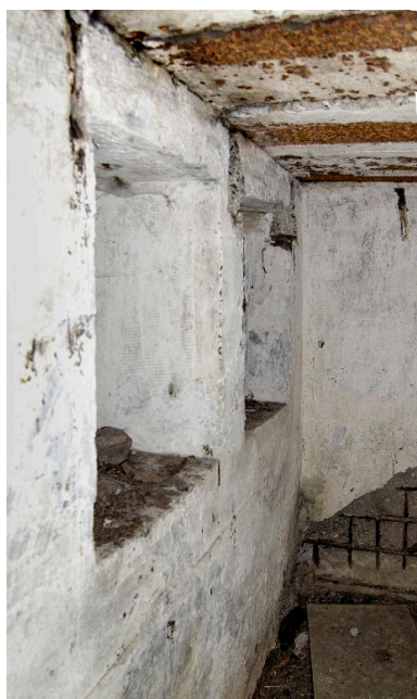
Vue intérieure (au grand angle) de la coursière de tir flanquant l'entrée est. Détail des coursières de tir Phot. Jean-Marc Ramette IVR32_20165901128NUCA
