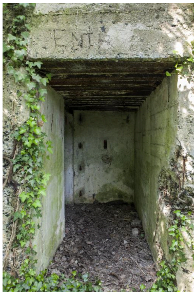
Entrée est. Au fond, on aperçoit le créneau de fusillade flanquant l'entrée. Phot. Jean-Marc Ramette IVR31_20145904868NUCA
