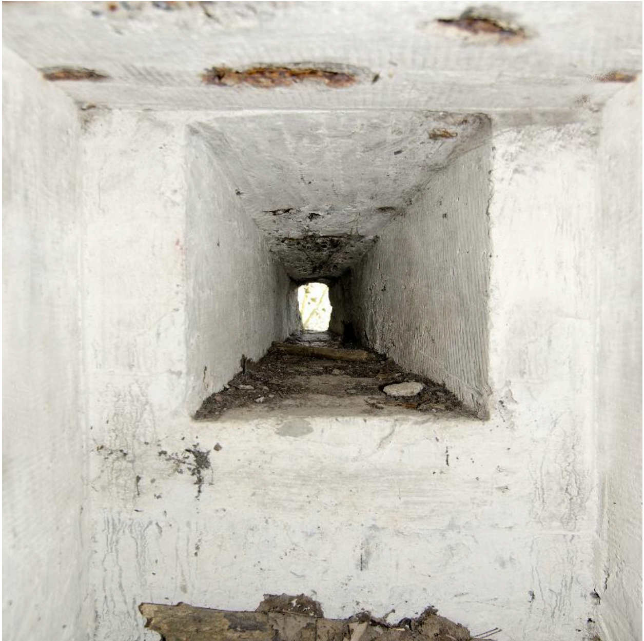
Un des créneaux de fusillade de la coursière de tir flanquant l'entrée ouest.
