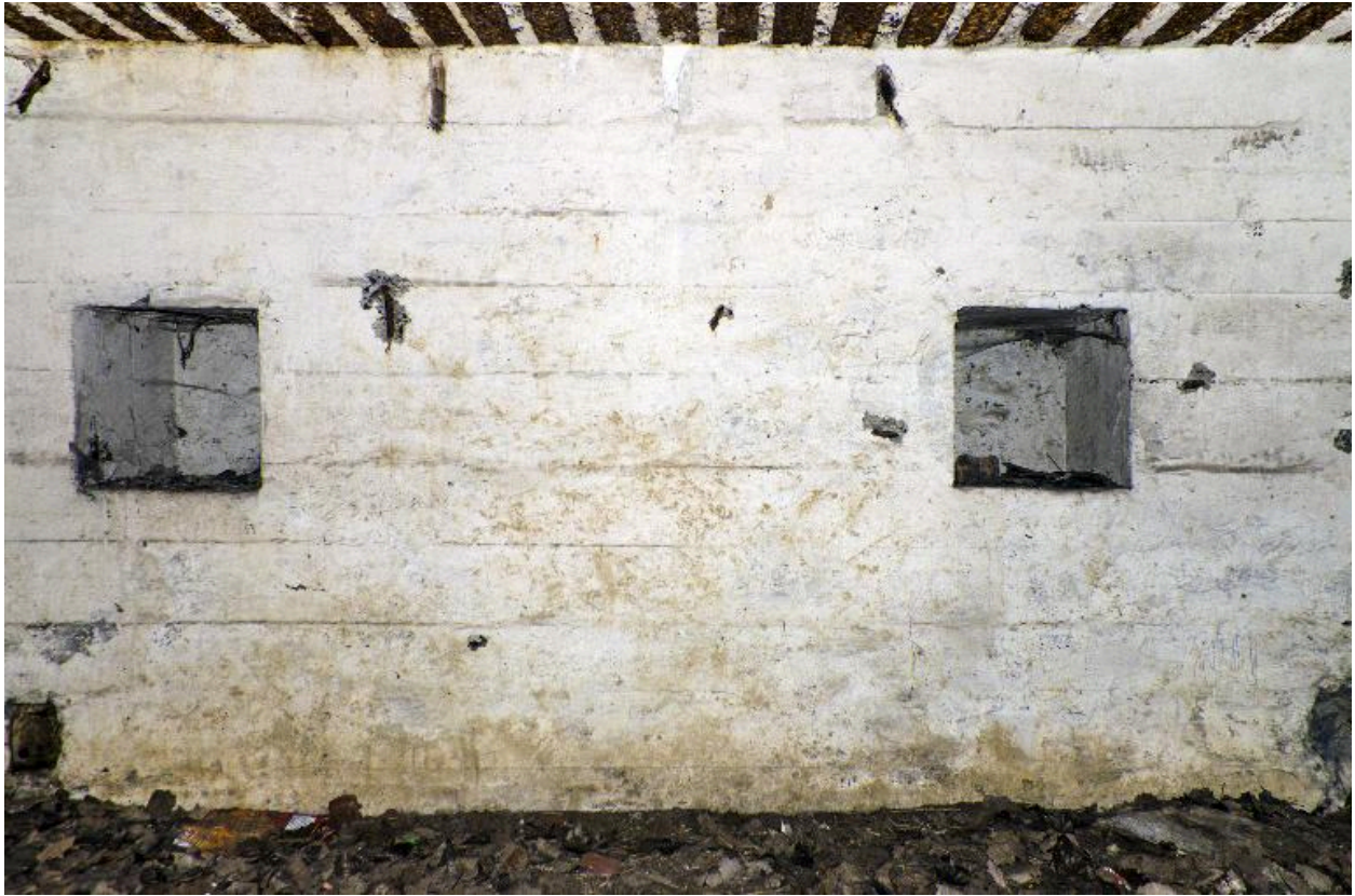
Vue intérieure (au grans angle). Niches dans le mur sud
