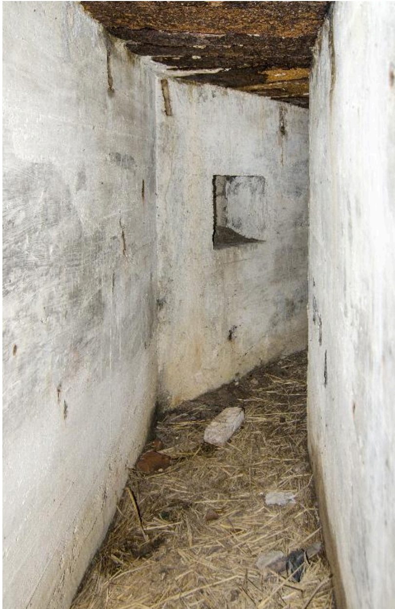
Vue intérieure (au grand angle et vers la salle) de la coursière de tir flanquant l'entrée ouest.
