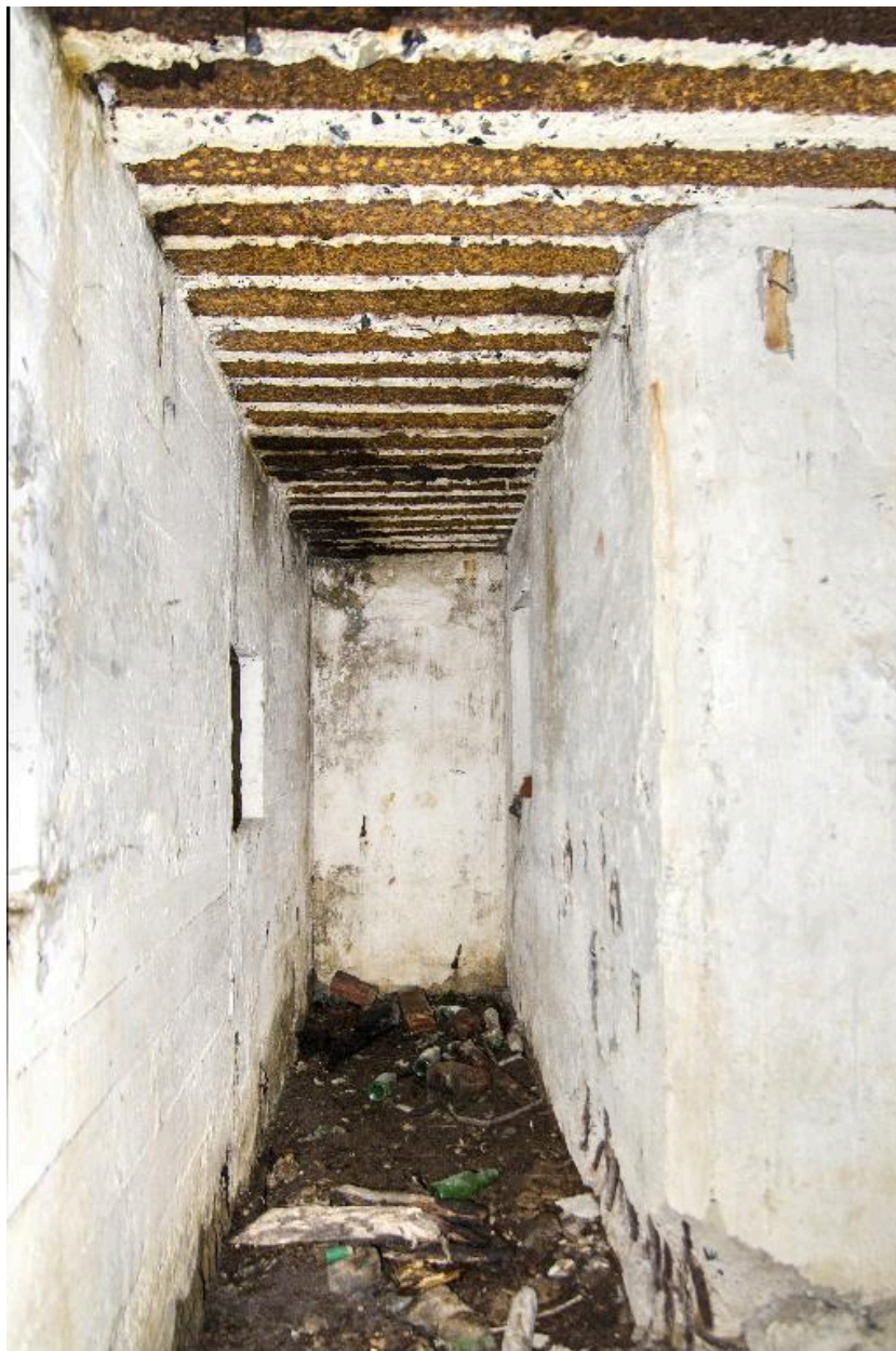
Vue intérieure (au grand angle) de la coursière de tir flanquant l'entrée est.
