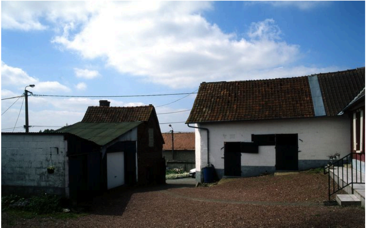
Vue des dépendances depuis la cour.
