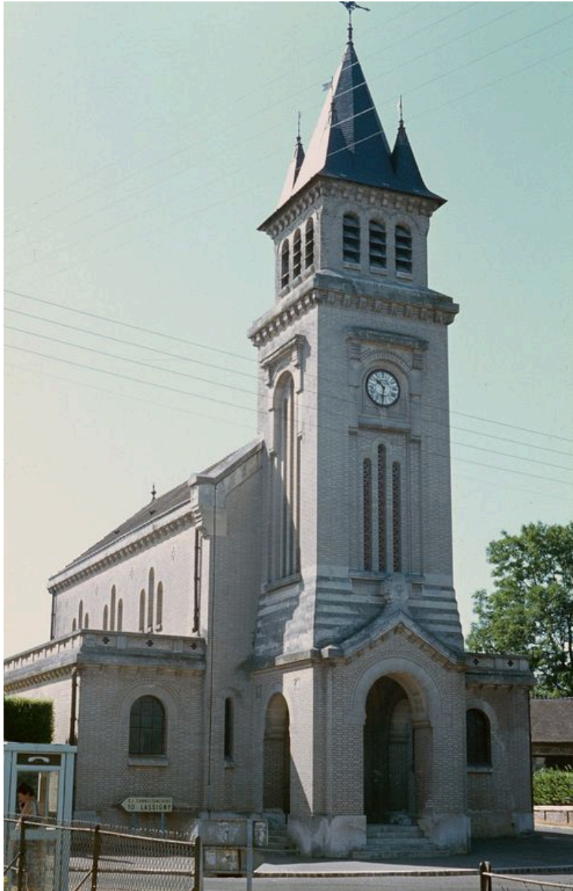
Ville. L'église paroissiale reconstruite en 1930.
