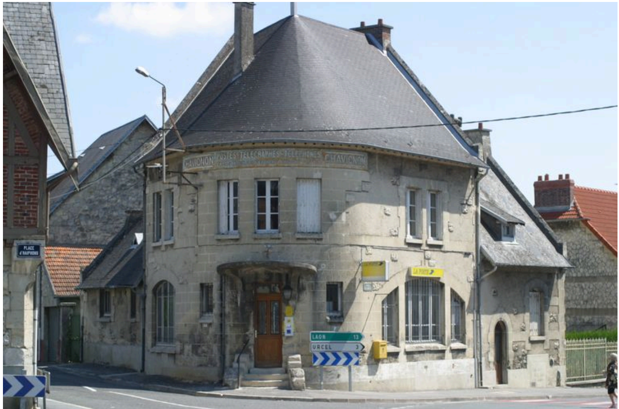
Chavignon. La poste reconstruite à l'identique.
