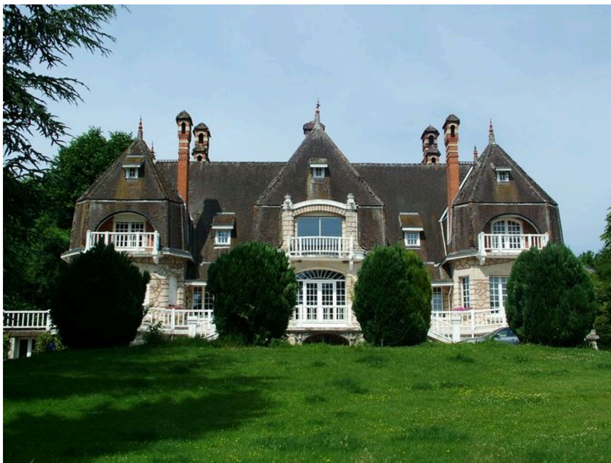
Craonelle. Le château reconstruit sur les plans de l'architecte Boessé (1926-1927).
