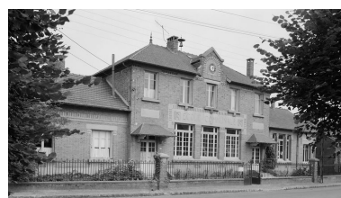
Varesne (Oise). La mairie et école reconstruite sur les plans de l'architecte Etienne Gaston (1924). Phot. Jean-Michel Périn IVR22_19846001100X
