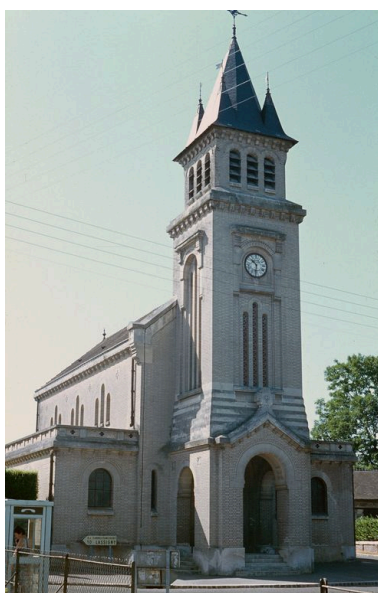
Ville. L'église paroissiale reconstruite en 1930. Phot. Martine Plouvier IVR22_19836000345ZA
