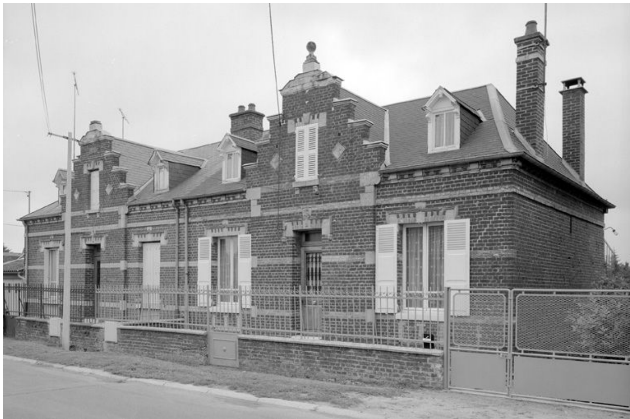
Pont-L'Évêque. Maison à deux unités d'habitation.
