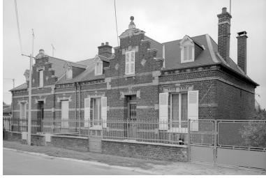
Pont-L'Évêque. Maison à deux unités d'habitation. Phot. Jean-Michel Périn IVR22_19856000948X
