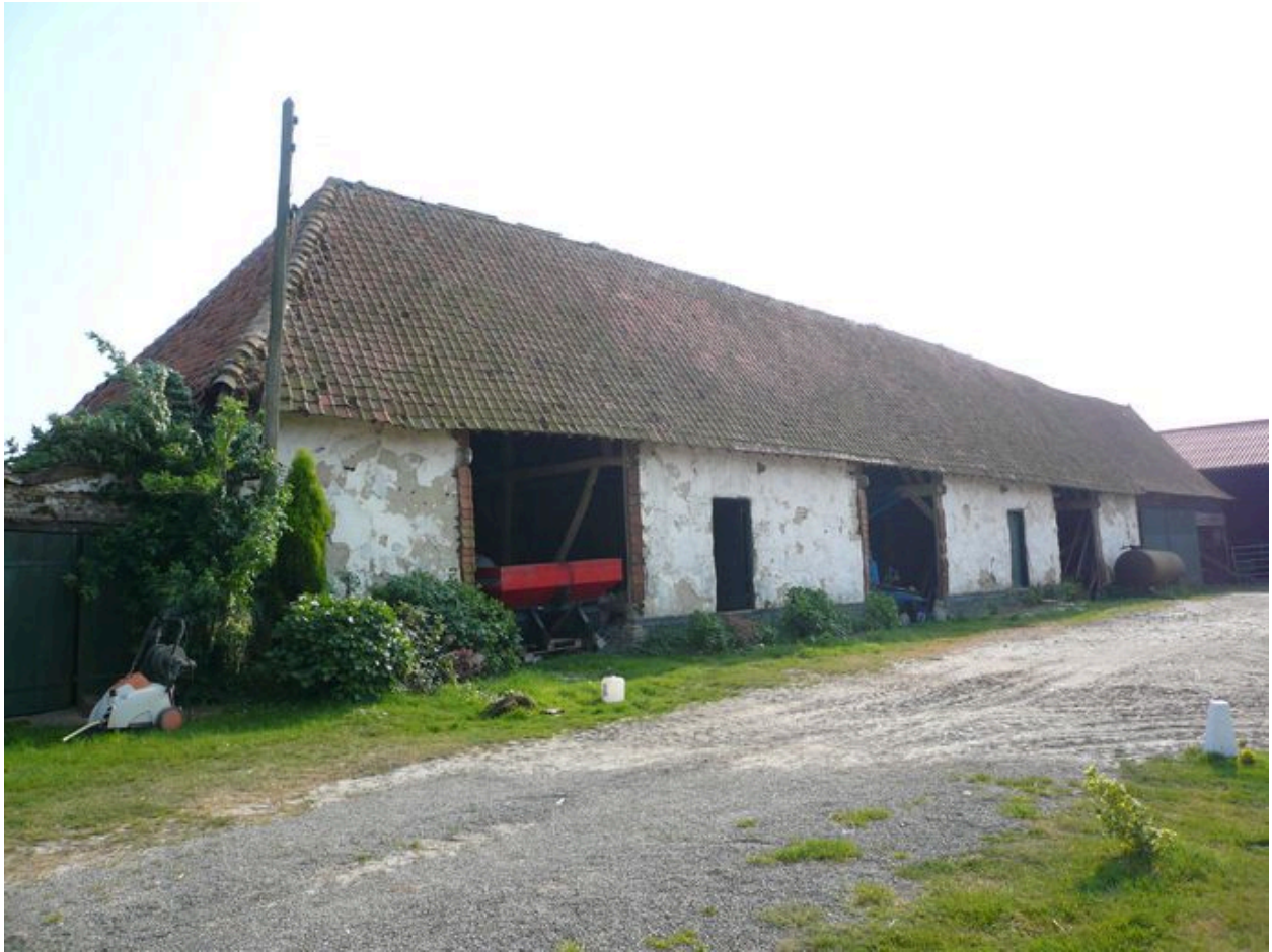
Vue de la grange dans le prolongement des étables à cochons vers l'ouest.
