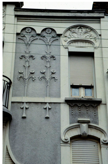
Vue partielle de la façade. Phot. Pierre Boissé IVR31_19885900023ZA
