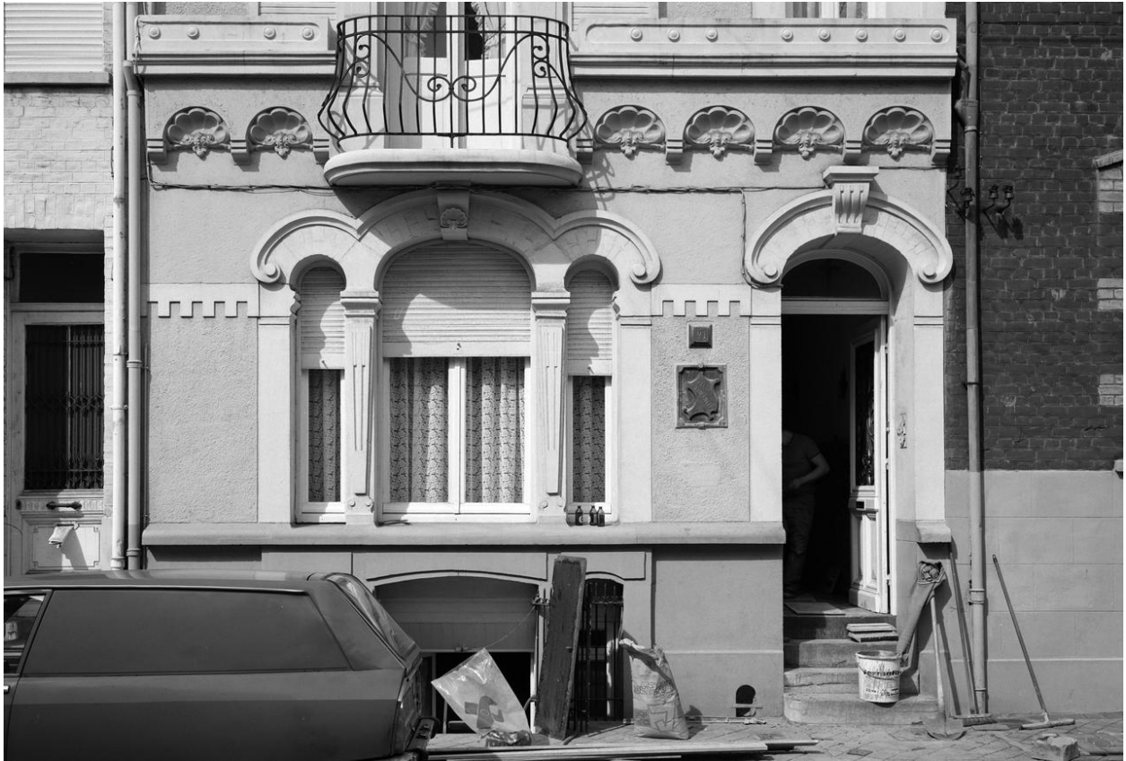
Détail de la façade : rez-de-chaussée.
