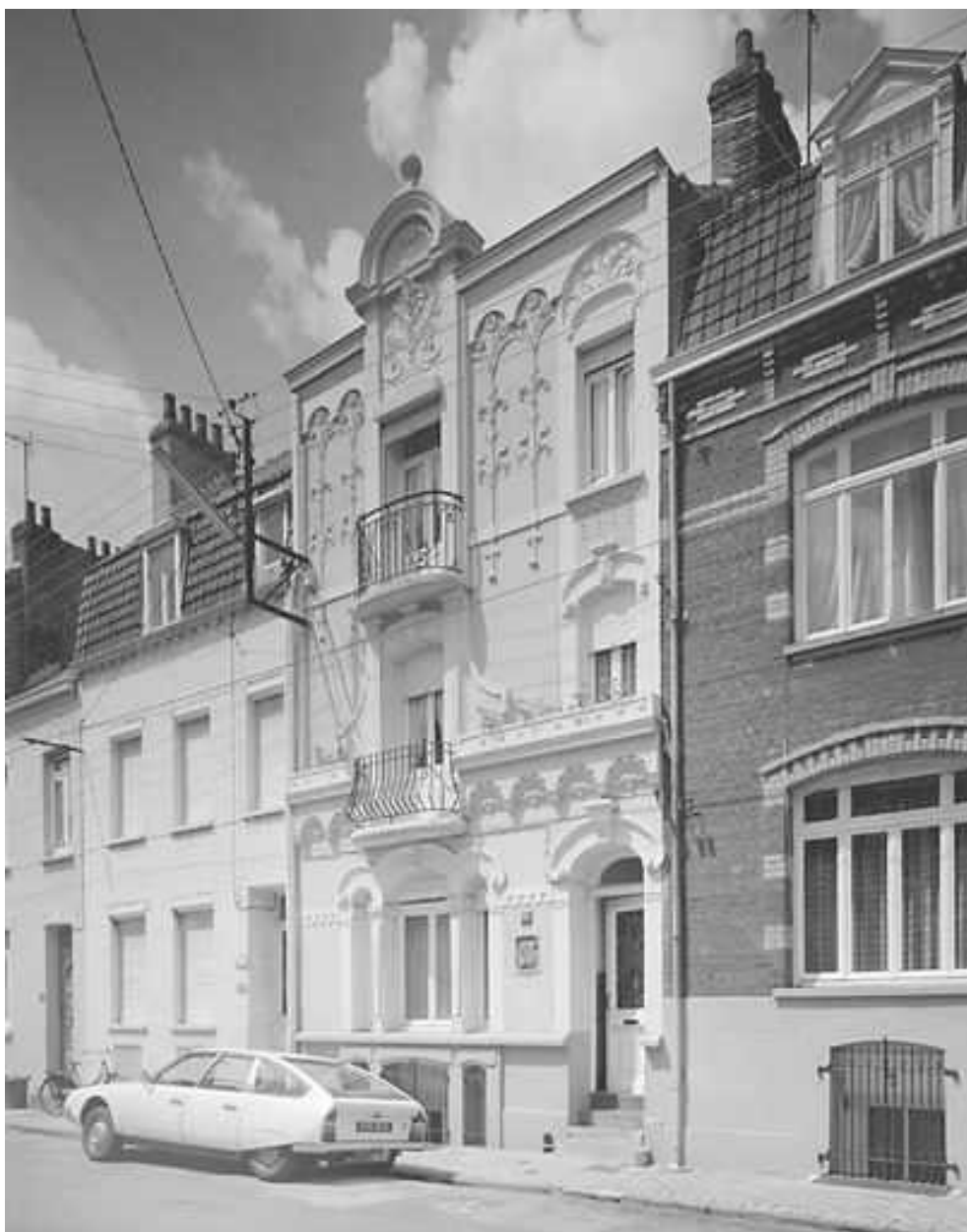
Vue d'ensemble de la façade.
