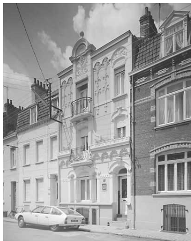
Vue d'ensemble de la façade. Phot. Eric Dessert IVR31_19815901065VA
