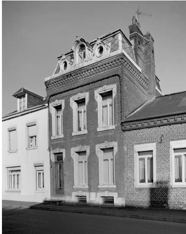
Vue générale. Phot. Thierry Lefébure IVR22_19960201008V
