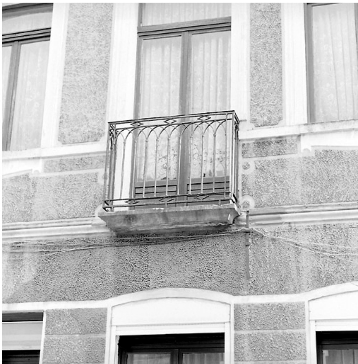
Façade du n° 80, détail : garde-corps du balcon.
