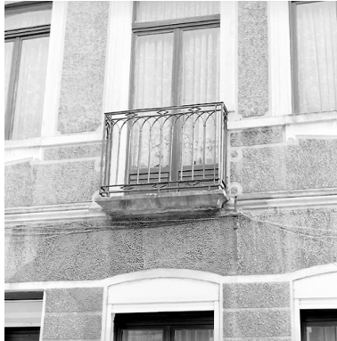
Façade du n° 80, détail : garde-corps du balcon.
