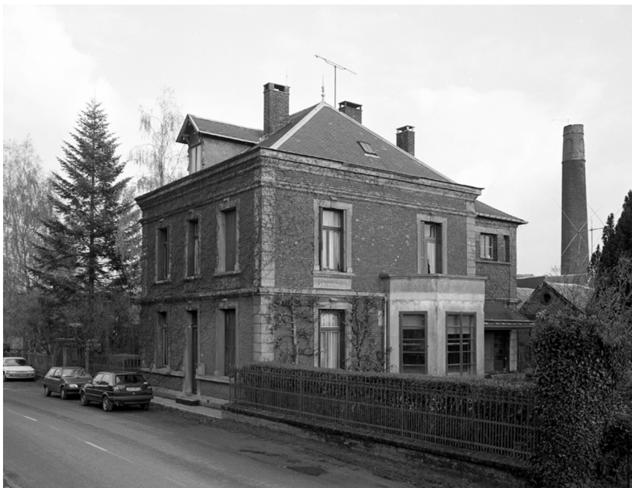
Vue générale du logement patronal.
