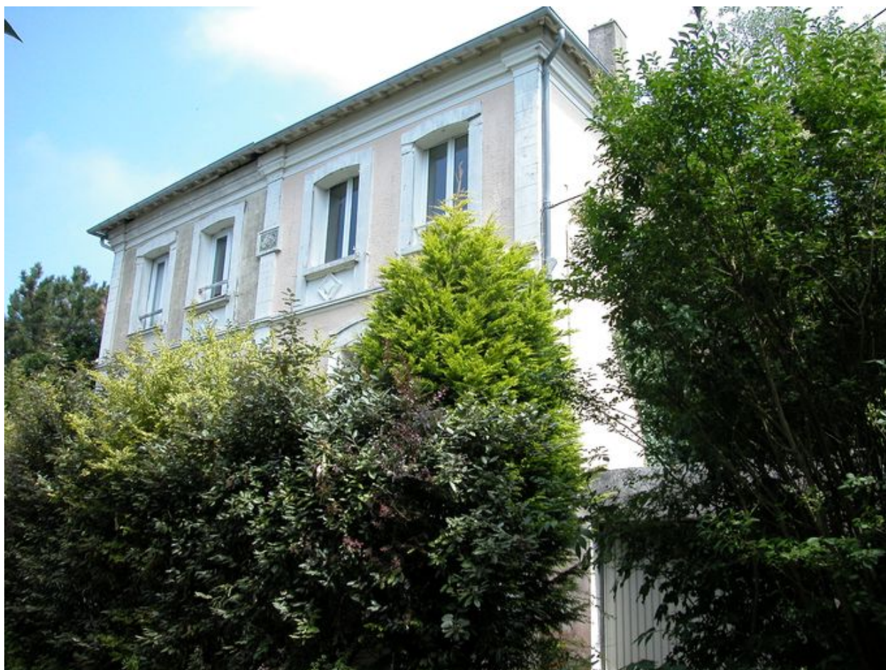
Vue de trois-quarts, façades sud et est.
