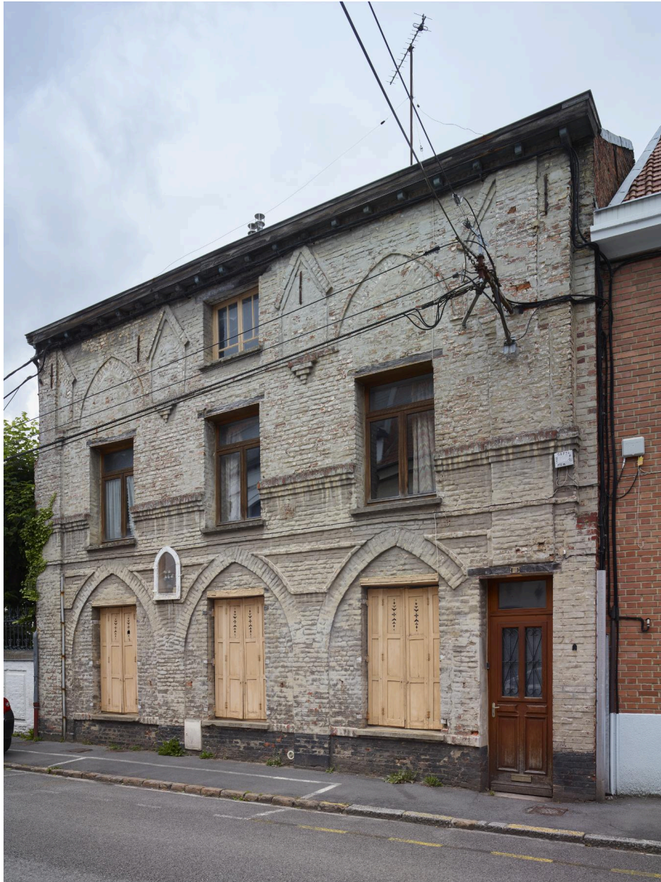
Ancien couvent des Sœurs Augustines : vue de la façade principale sur la rue Achille Carlier.
