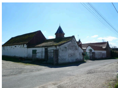
Vue d'ensemble. Phot. Inès Guérin IVR22_20078005748NUCA
