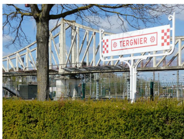
Panneau indicateur de la gare de Tergnier. Phot. Isabelle Barbedor IVR32_20210205033NUCA
