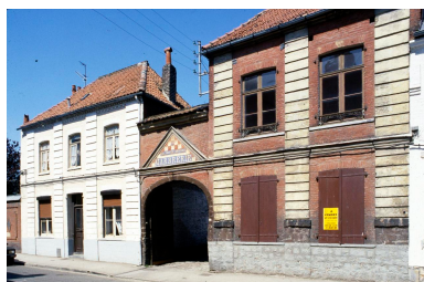
Ensemble des bâtiments donnant sur la rue du Château. Phot. Philippe Dapvril IVR31_19876200407ZA
