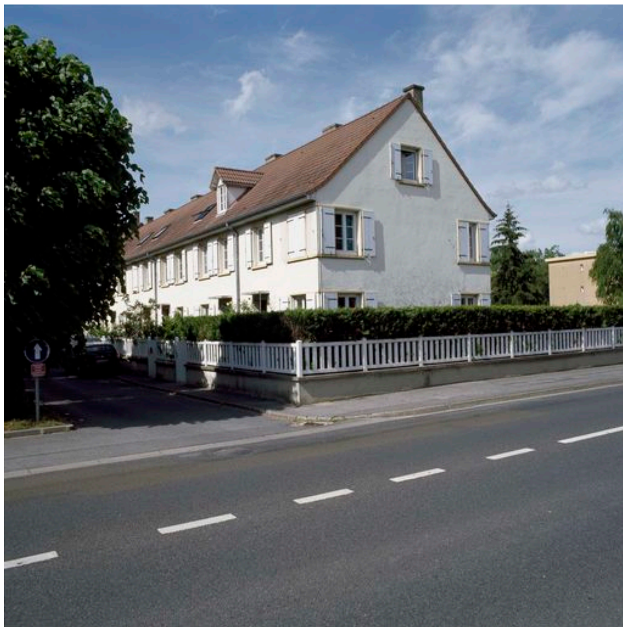
Vue d'un des immeubles à logements.
