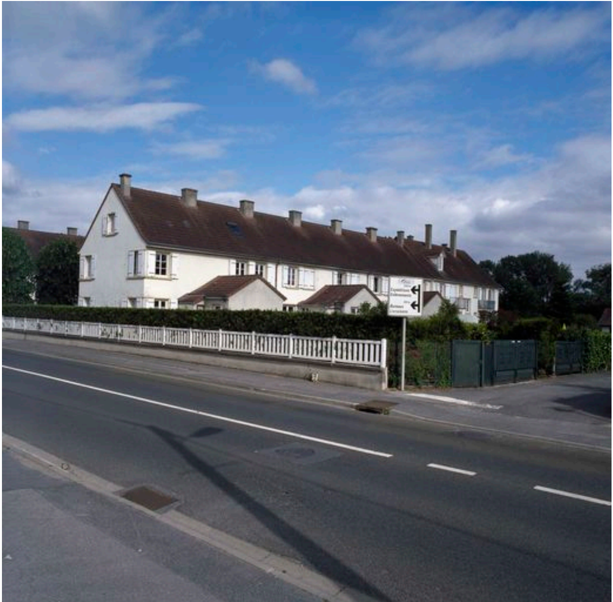
Vue générale depuis l'arrière des logements.
