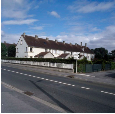
Vue générale depuis l'arrière des logements. Phot. Thierry Lefébure IVR22_20106000359XA
