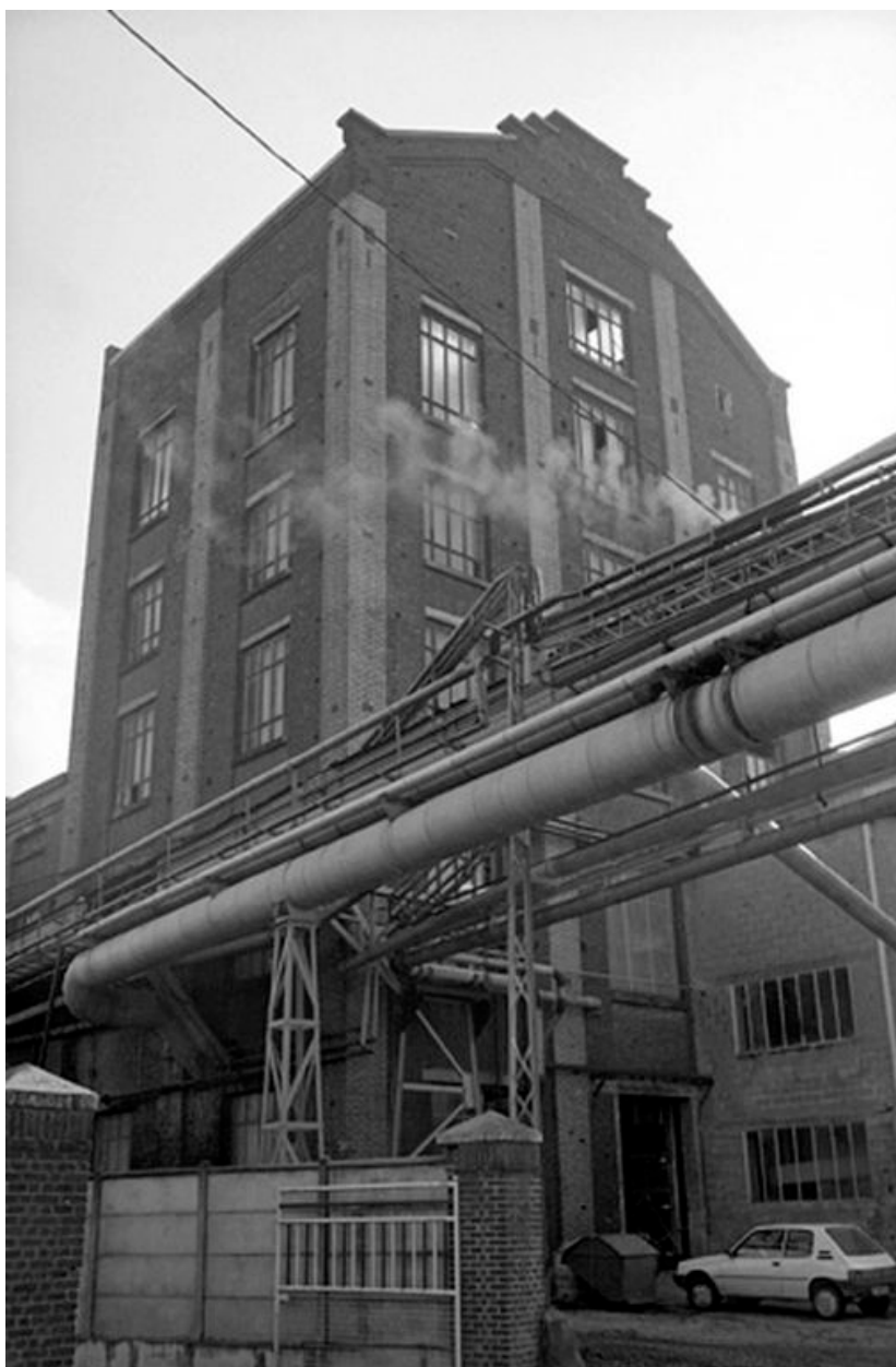
Atelier de fabrication, flanc ouest.
