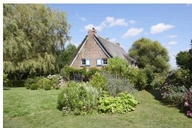
Pignon sud-ouest et jardin. Phot. Delphine Volto-Jourdan IVR32_20245902833NUCA
