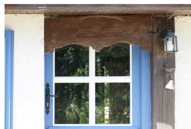
Façade sud-est. Porte d'entrée. Date portée et inscription sur le linteau en bois "MARCUS DE WAELE / AN-1752-NO" Phot. Delphine Volto-Jourdan IVR32_20245902831NUCA
