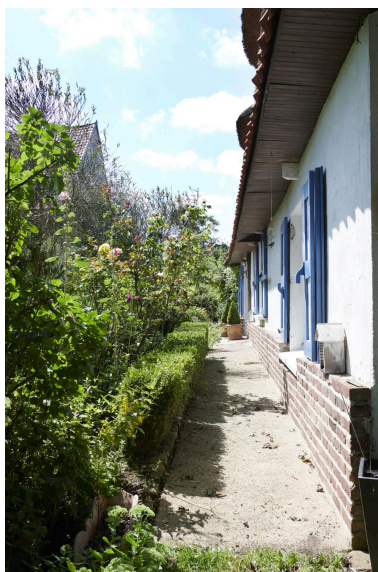
Bordure de la façade sud-est. Phot. Delphine Volto-Jourdan IVR32_20245902829NUCA
