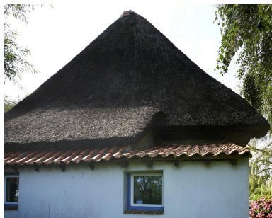
Pignon nord-est. Phot. Delphine Volto-Jourdan IVR32_20245902828NUCA
