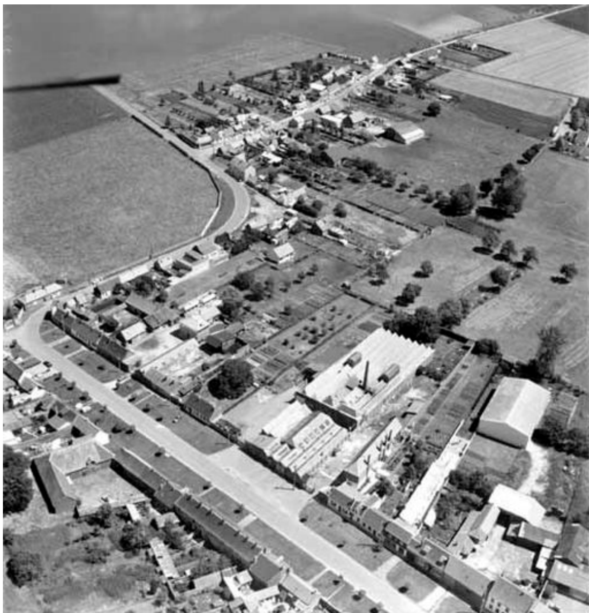
Vue aérienne, flanc sud-ouest.
