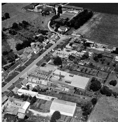
Vue aérienne, flanc sud.
