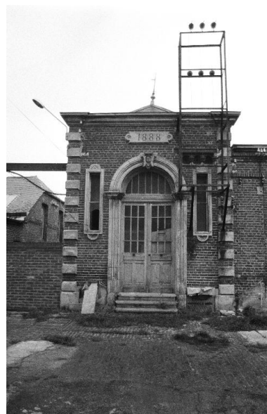
Salle des machines.
