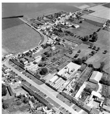
Vue aérienne, flanc sud-ouest.
