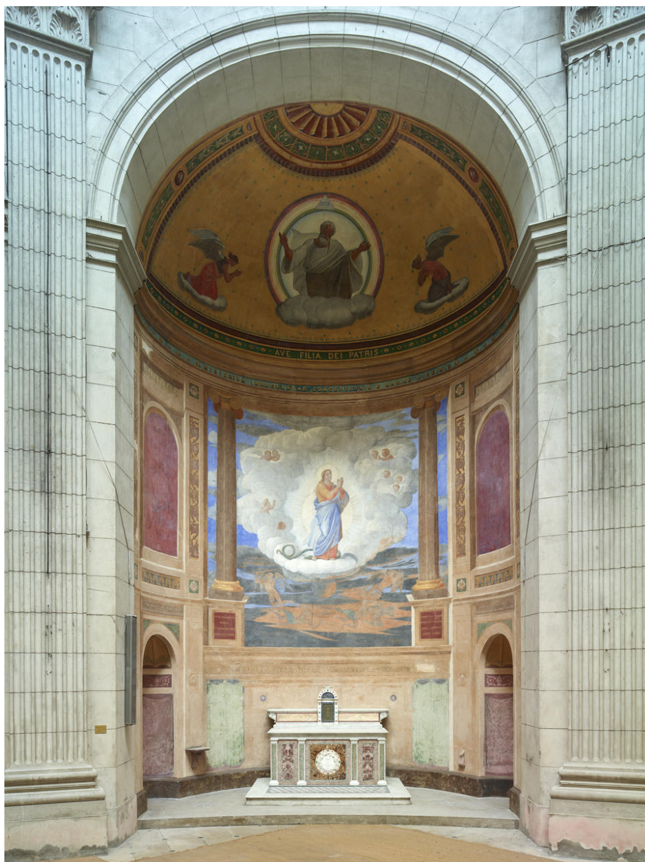
Vue générale après restauration.
