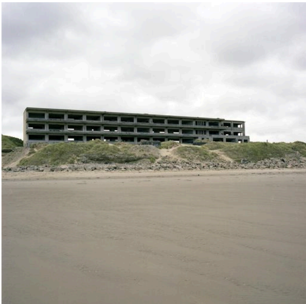
Elévation antérieure, vue générale prise de face.
