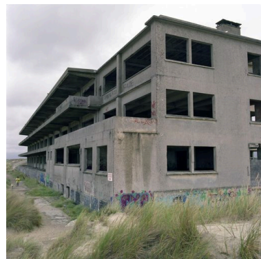
Elévation antérieure donnant sur la plage, vue en enfilade prise depuis le flanc sud. Phot. Pierre Thibaut IVR31_20096200036XE
