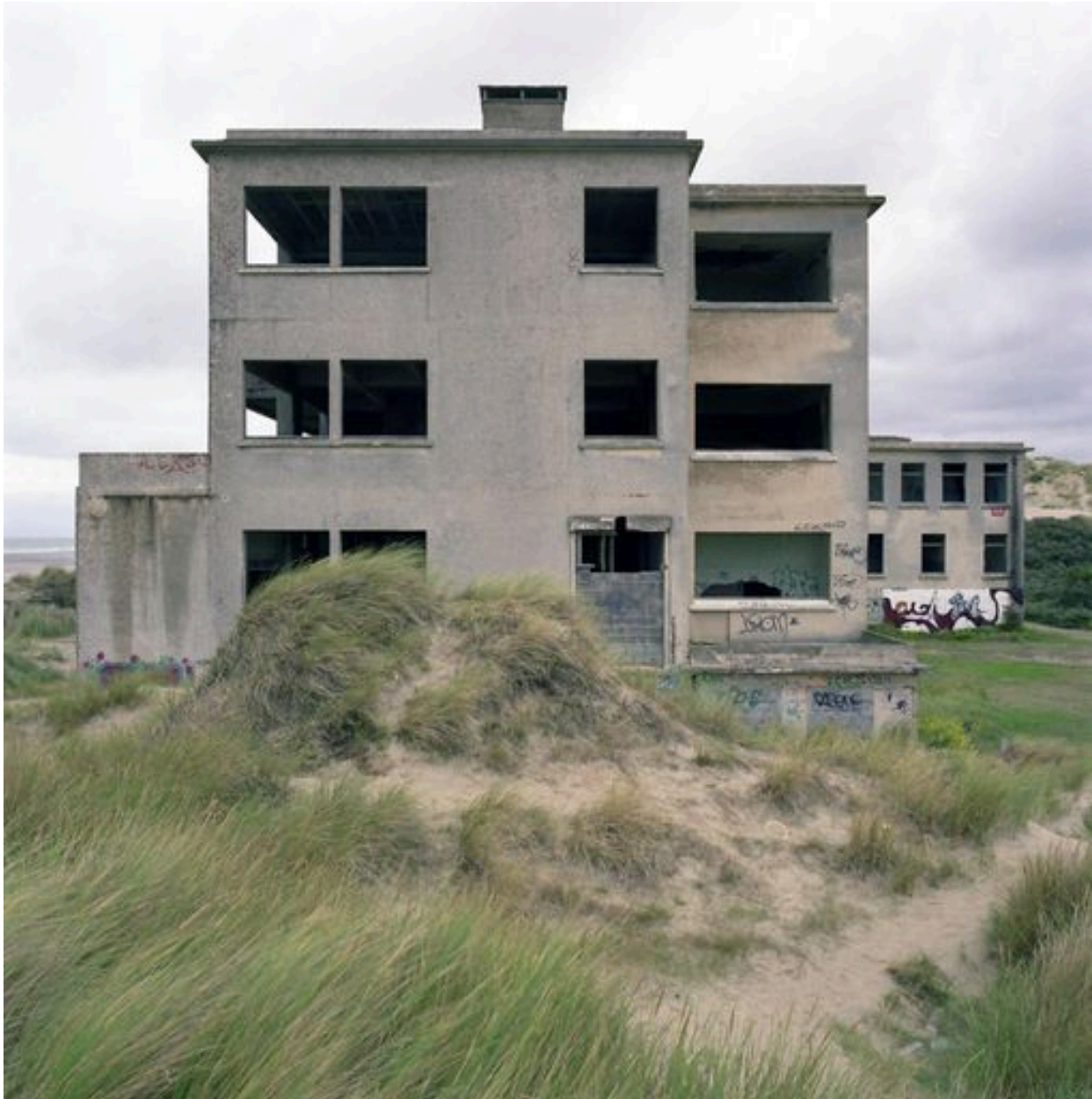
Elévation latérale sud, vue générale.
