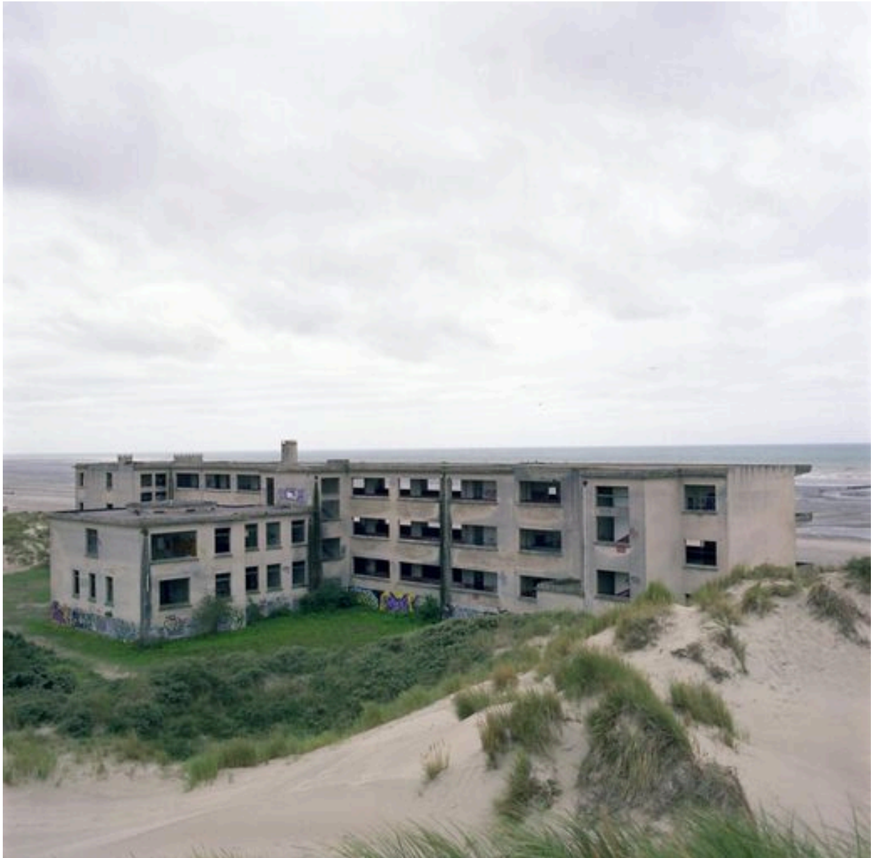
Elévation postérieure, vue générale prise de trois-quarts droit.
