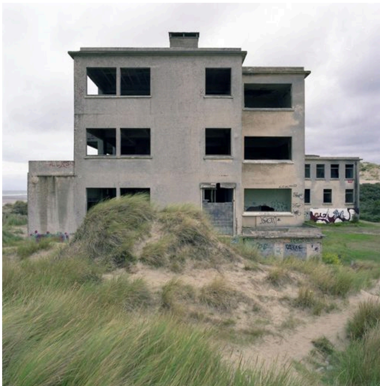
Elévation latérale sud, vue générale.
