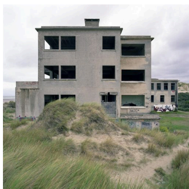
Elévation latérale sud, vue générale. Phot. Pierre Thibaut IVR31_20096200034XE
