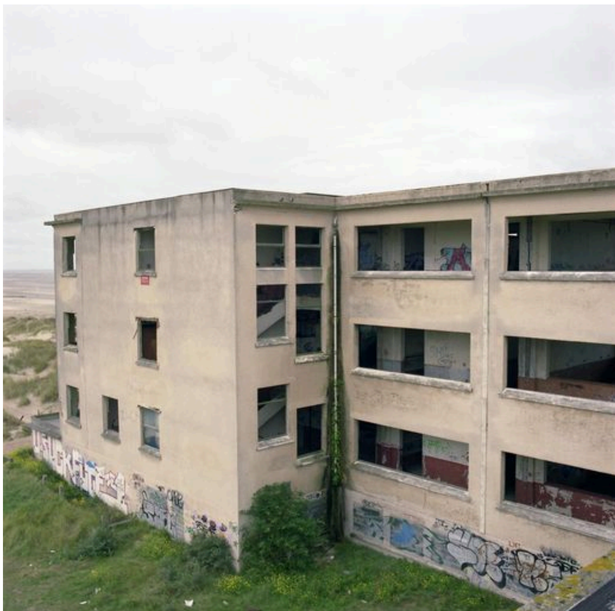
Détail de la moitié sud du bâtiment d'hospitalisation, élévation postérieure, vue prise de trois-quarts droit.
