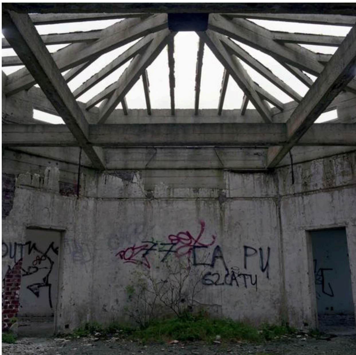
Aile devant renfermer les services médico-techniques, située sur l'arrière du bâtiment d'hospitalisation, couverture de la salle d'opération, vue prise de l'intérieur de la salle.
