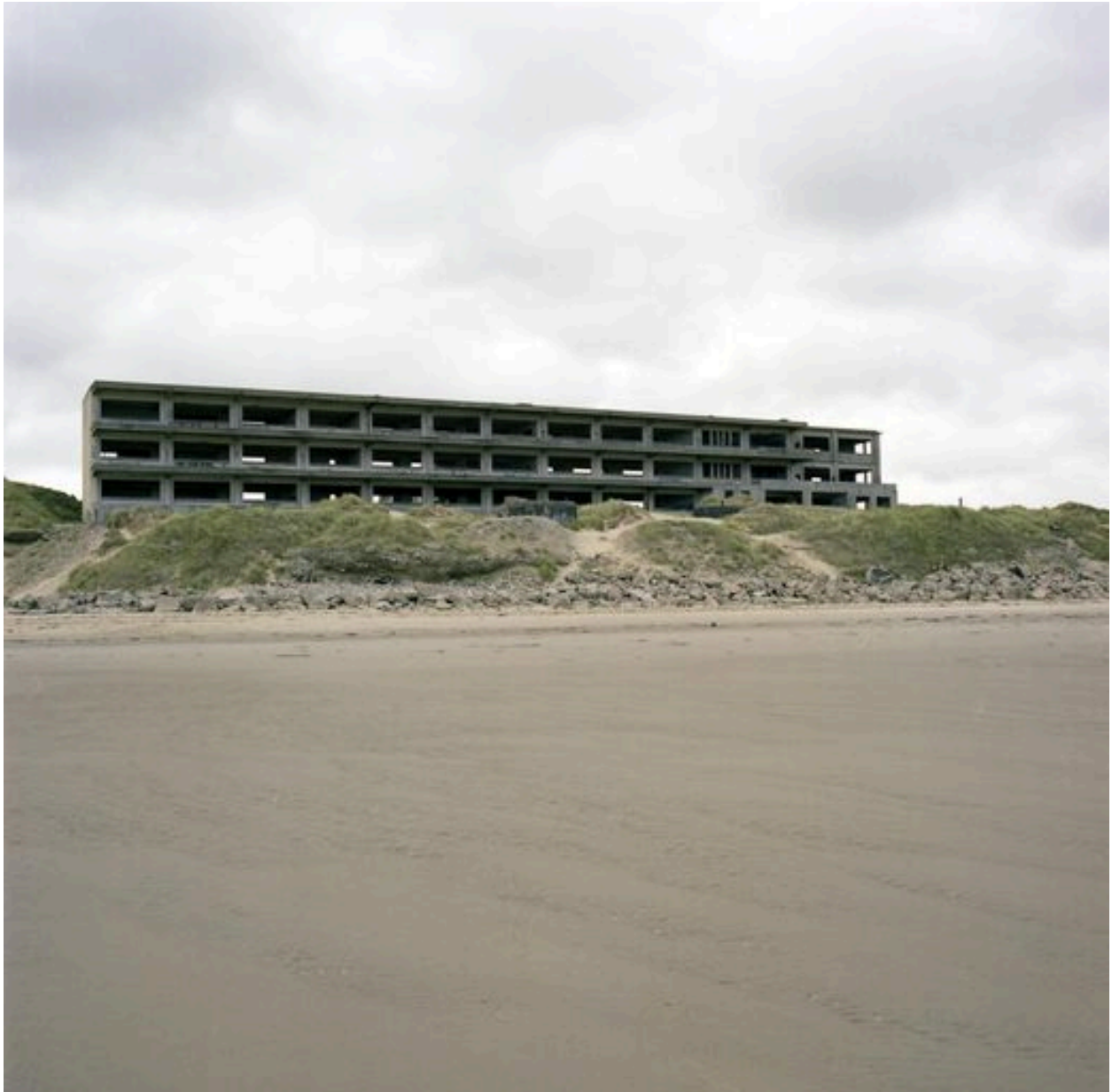
Elévation antérieure, vue générale prise de face.
