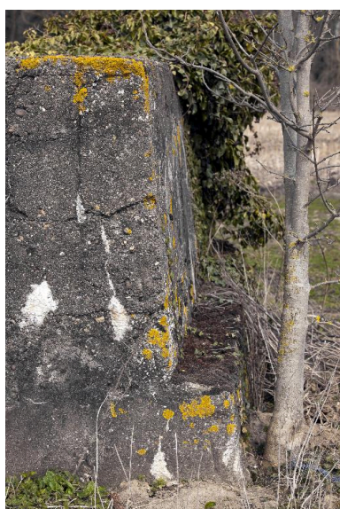
Position de tir Phot. Jean-Marc Ramette IVR31_20145904006NUCA
