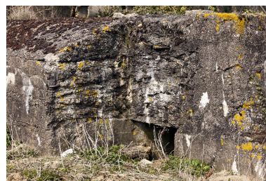
Entrée sud Phot. Jean-Marc Ramette IVR31_20145904004NUCA
