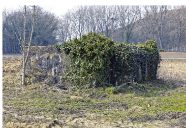
Vue générale vers le sud-ouest Phot. Jean-Marc Ramette IVR31_20145904001NUCA
