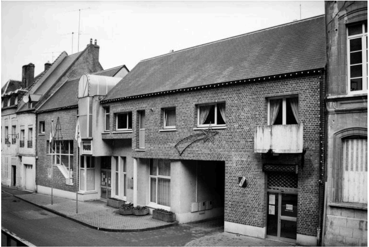
Vue de la façade sur rue.
