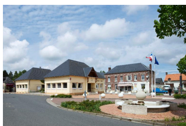
Vue de trois-quarts sud-est. Phot. Thierry Lefébure IVR22_20138000269NUC2A
