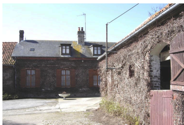
Vue détaillée du logis. Phot. Inès Guérin IVR22_20058005484NUCA
