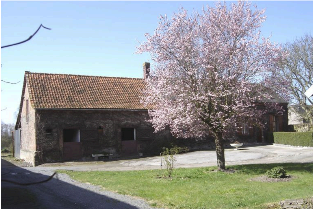
Vue de l'écurie et du logis dans le prolongement.
