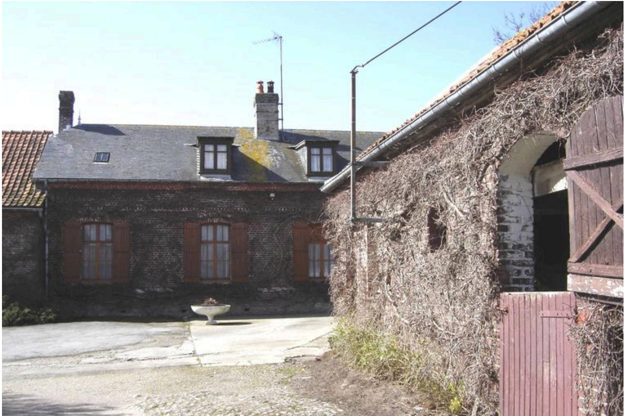
Vue détaillée du logis.
