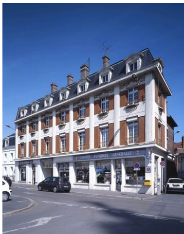
Vue générale. Phot. Pierre Thibaut IVR31_20086200134VA
