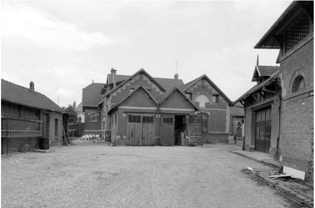
Magasin coopératif La Prévoyance (rue Thiers), en 1991 : élévation postérieure.
