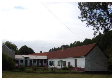
Vue générale. Phot. Inès Guérin IVR22_20068005020NUCA
