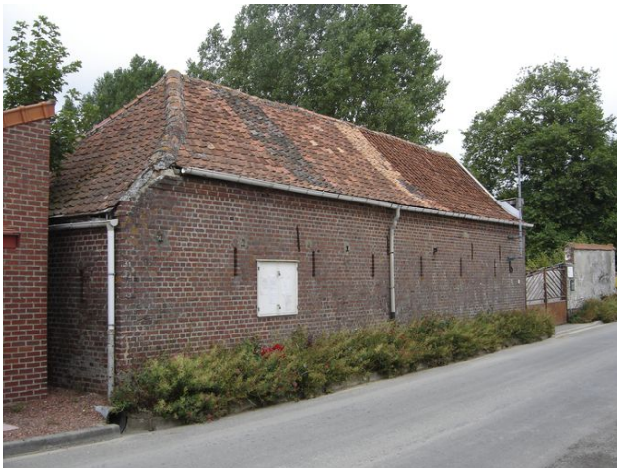
Vue des étables depuis la rue.
