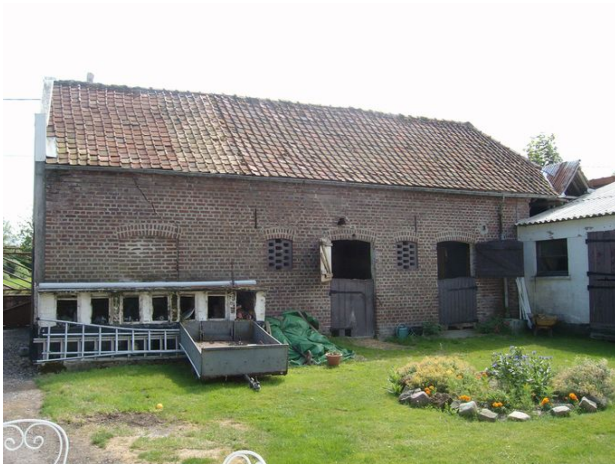
Vue des étables sur rue depuis la cour.
