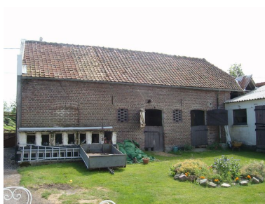
Vue des étables sur rue depuis la cour. Phot. Inès Guérin IVR22_20068005029NUCA
