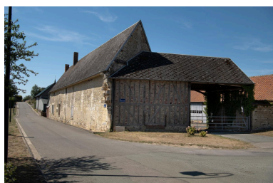
Bâtiment de l'ancienne ferme seigneuriale, n°56 Grande Rue. Phot. Marc Kérignard IVR32_20226000843NUCA
