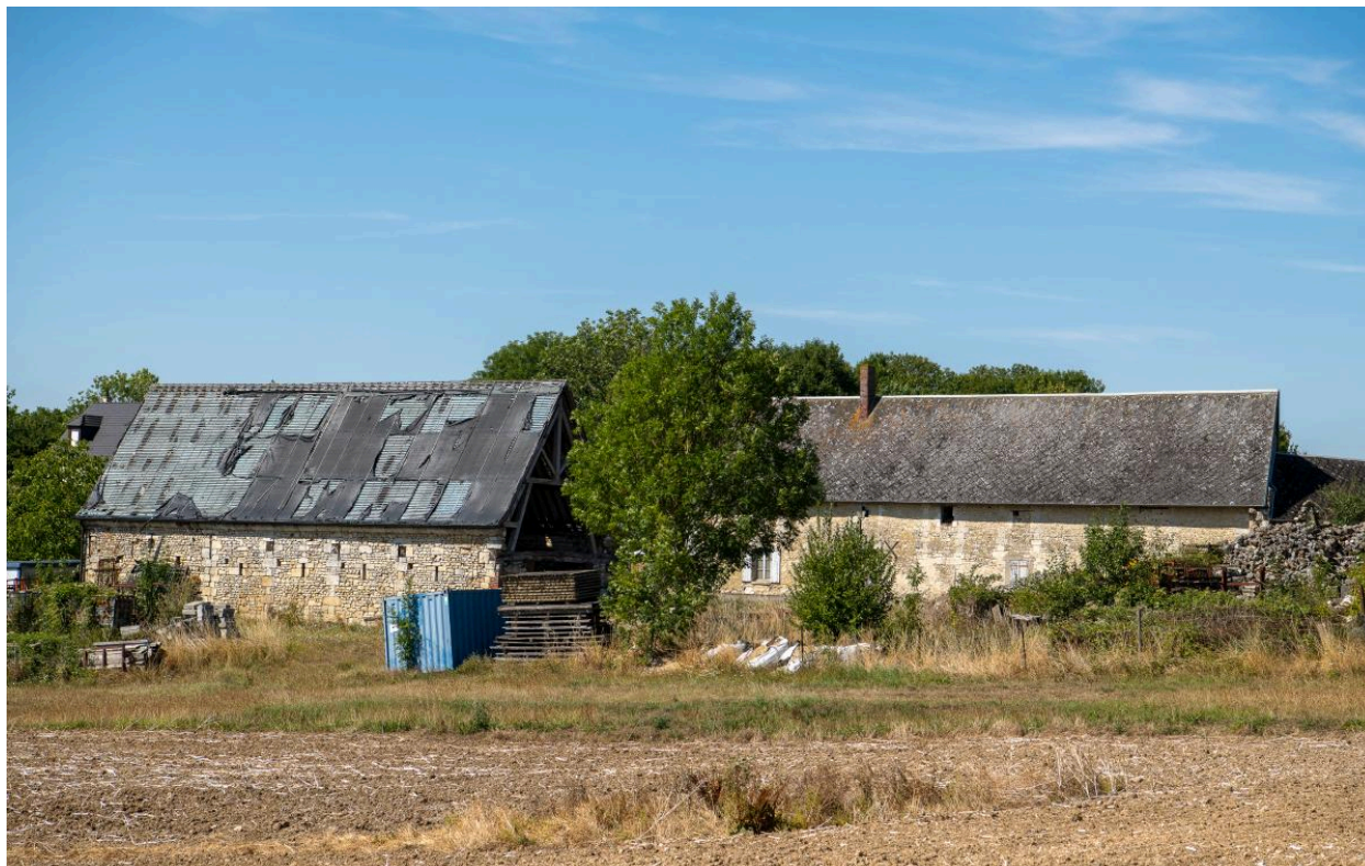
Deux bâtiments de l'ancienne ferme seigneuriale du Quesnel-Aubry, vue depuis la rue du Plessier-sur-Bulles.
