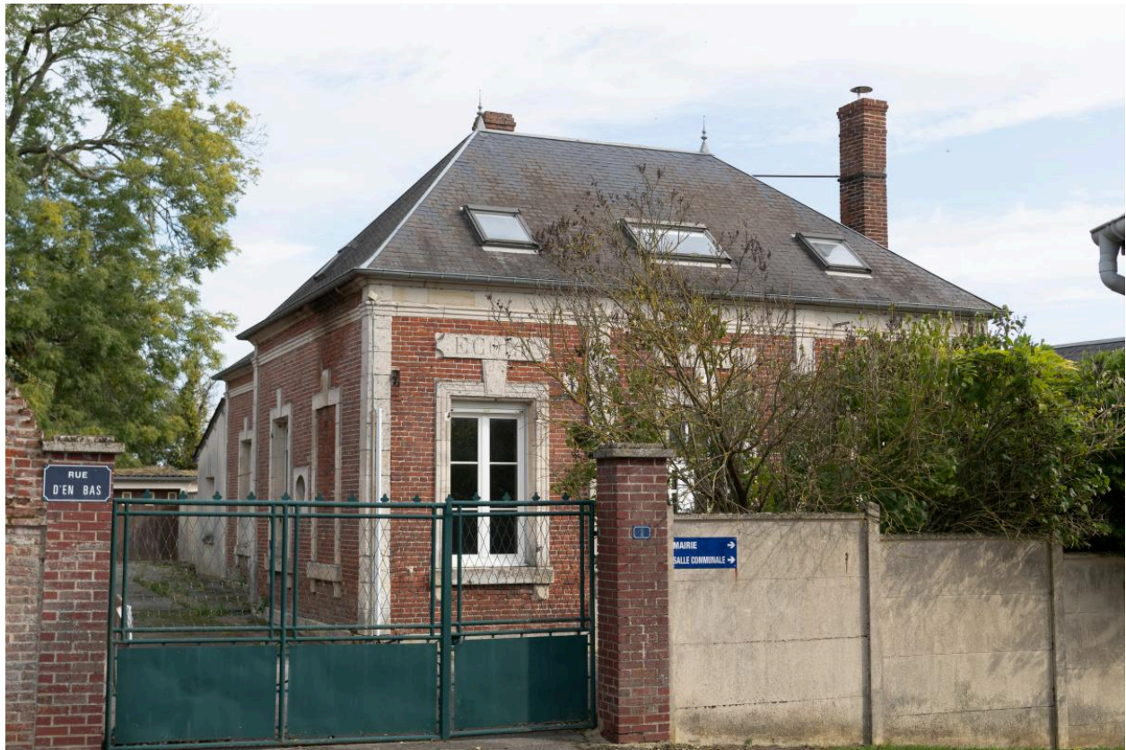
Ancienne mairie-école, vue depuis l'ouest.
