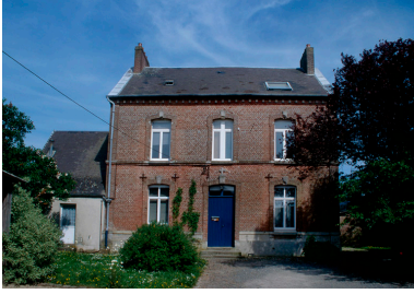
Elévation antérieure. Phot. Irwin Leullier IVR22_20018000119ZA
