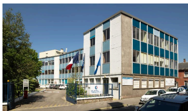
Immeuble de bureaux de la Chambre de commerce. Vue depuis la rue du Chevalier-de-la-Barre. Phot. Marie-Laure Monnehay-Vulliet IVR32_20178000235NUC2A
