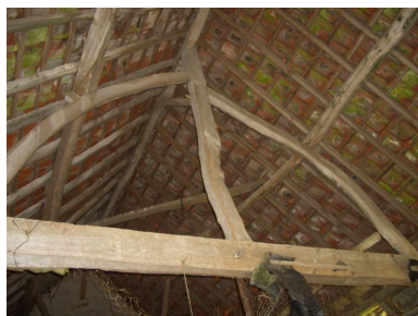
Vue d'une ferme de la charpente de la charreterie. Phot. Inès Guérin IVR22_20068005430NUCA
