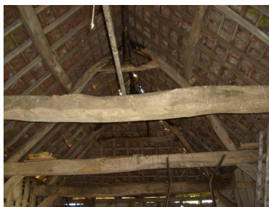
Autre système de charpente. Phot. Inès Guérin IVR22_20068005431NUCA
