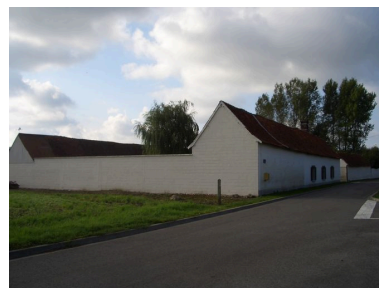
Vue générale. Phot. Inès Guérin IVR22_20068005422NUCA
