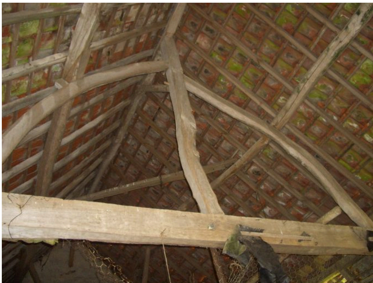
Vue d'une ferme de la charpente de la charreterie.
