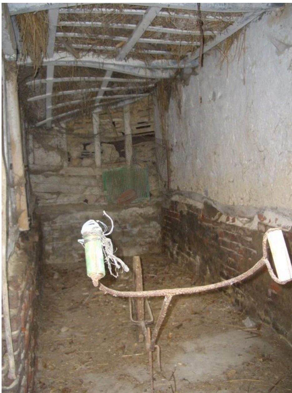
Vue intérieure d'une étable à cochon.
