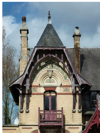
Détail du pignon en retour.
