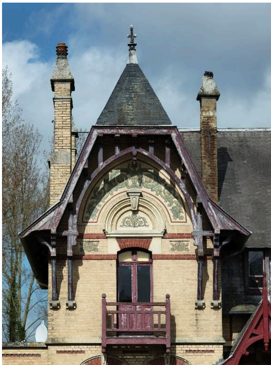
Détail du pignon en retour.
