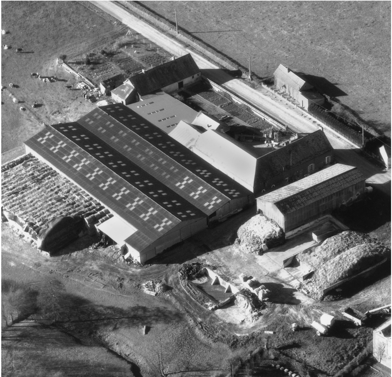
Vue aérienne de la ferme depuis l'est.
