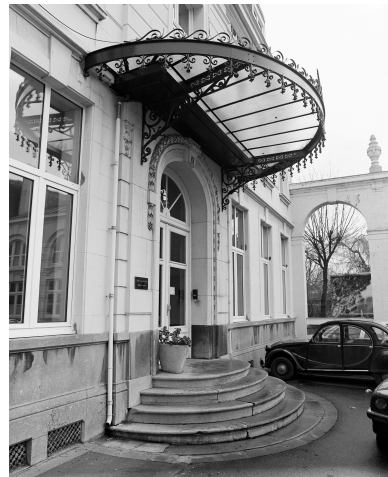
Perron et marquise du bâtiment principal. Phot. Olivier Marlard IVR31_19885902348X
