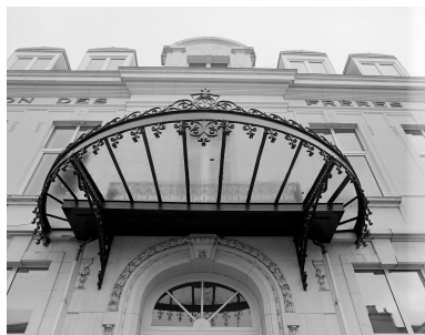
Marquise surmontant l'entrée du bâtiment principal. Phot. Olivier Marlard IVR31_19885902347X
