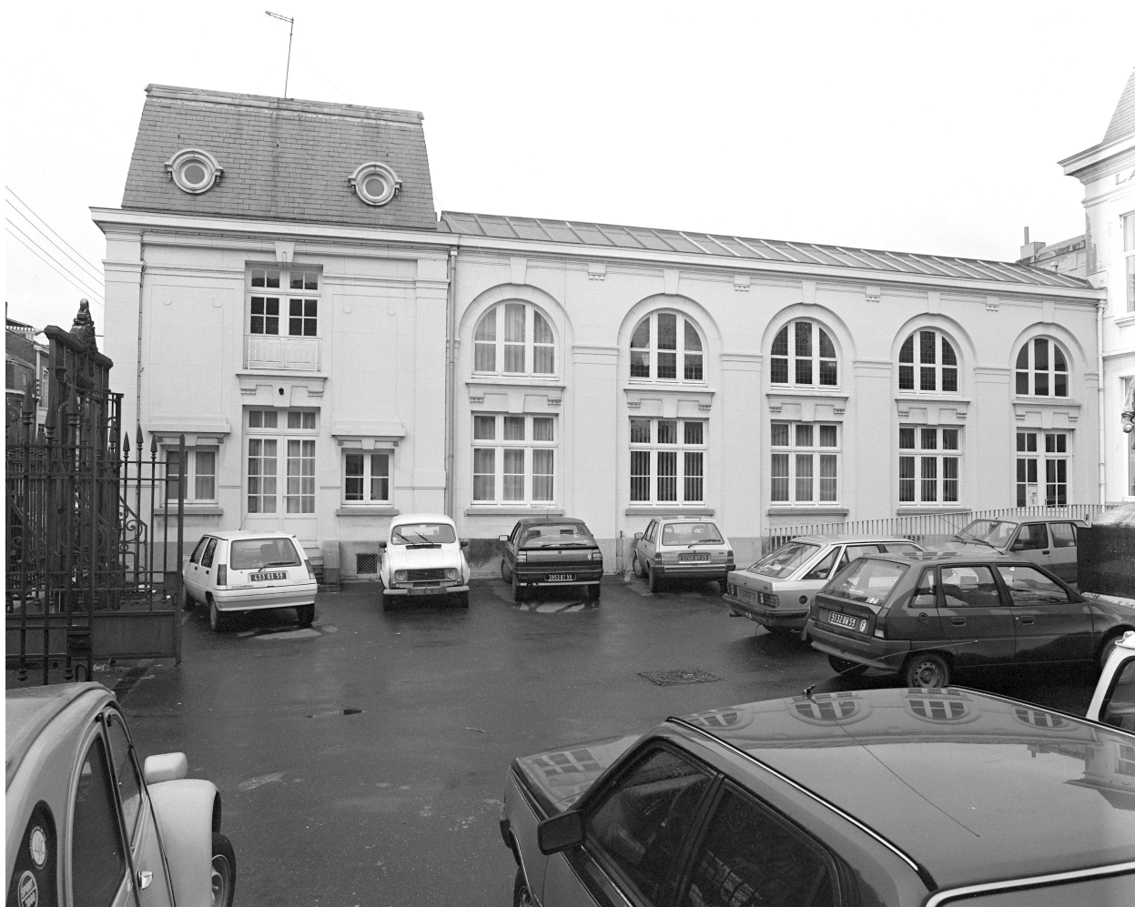
Aile ouest, élévation sur cour.
