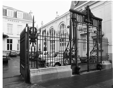
Détail de la grille d'entrée. Phot. Olivier Marlard IVR31_19885902350X
