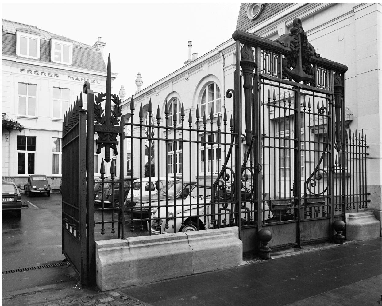
Détail de la grille d'entrée.
