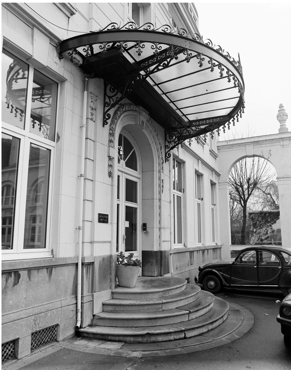
Perron et marquise du bâtiment principal.
