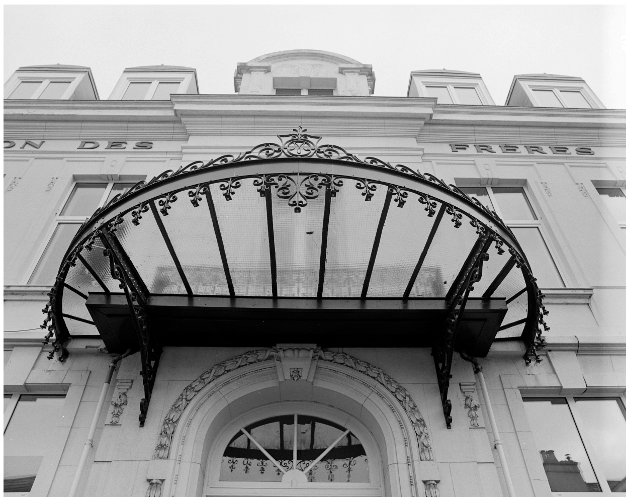
Marquise surmontant l'entrée du bâtiment principal.
