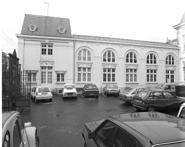
Aile ouest, élévation sur cour. Phot. Olivier Marlard IVR31_19885902346X
