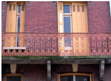
Détail du balcon de ferronnerie. Phot. Elisabeth Justome IVR22_20048001394NUCA
