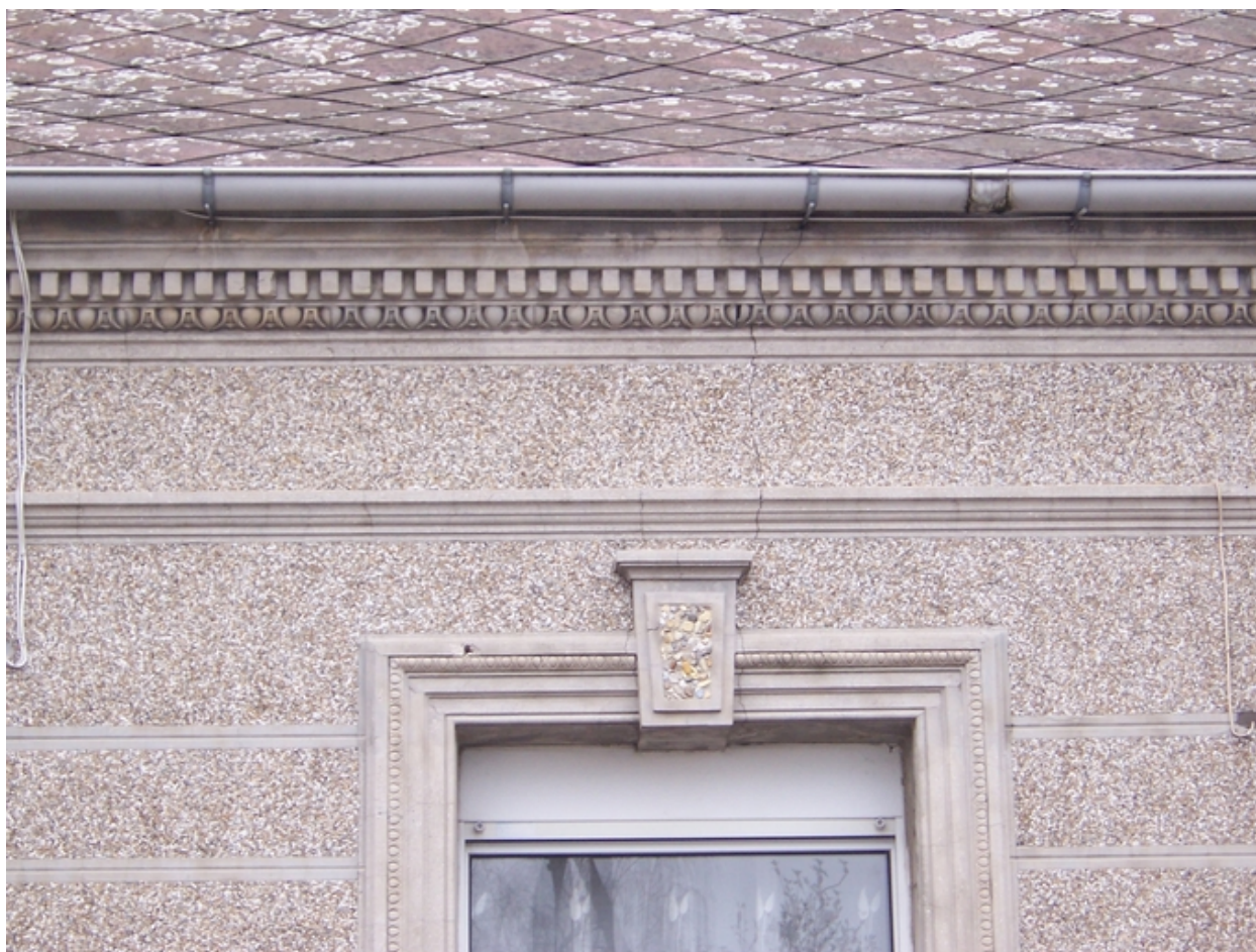
Détail de la façade en gravier roulé.
