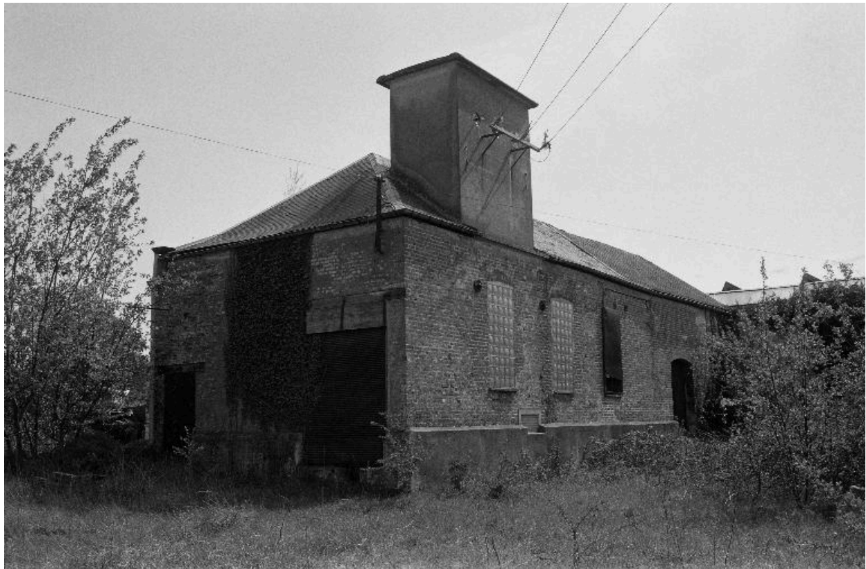
Chaufferie (?) et transformateur.
