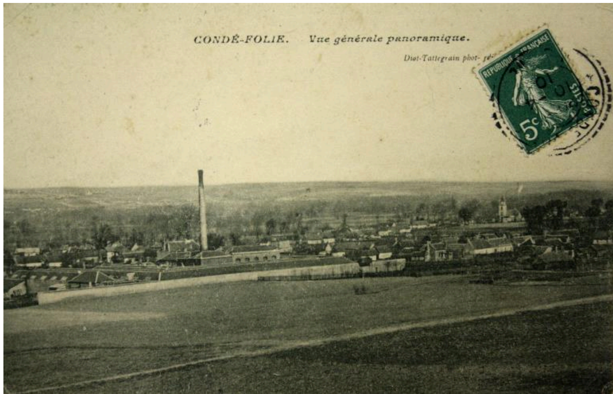
Vue panoramique du village dominée par la cheminée de l'usine, carte postale vers 1910 (coll. part.).
