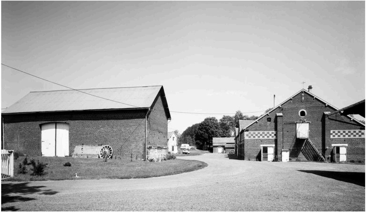
Ferme. Vue générale.
