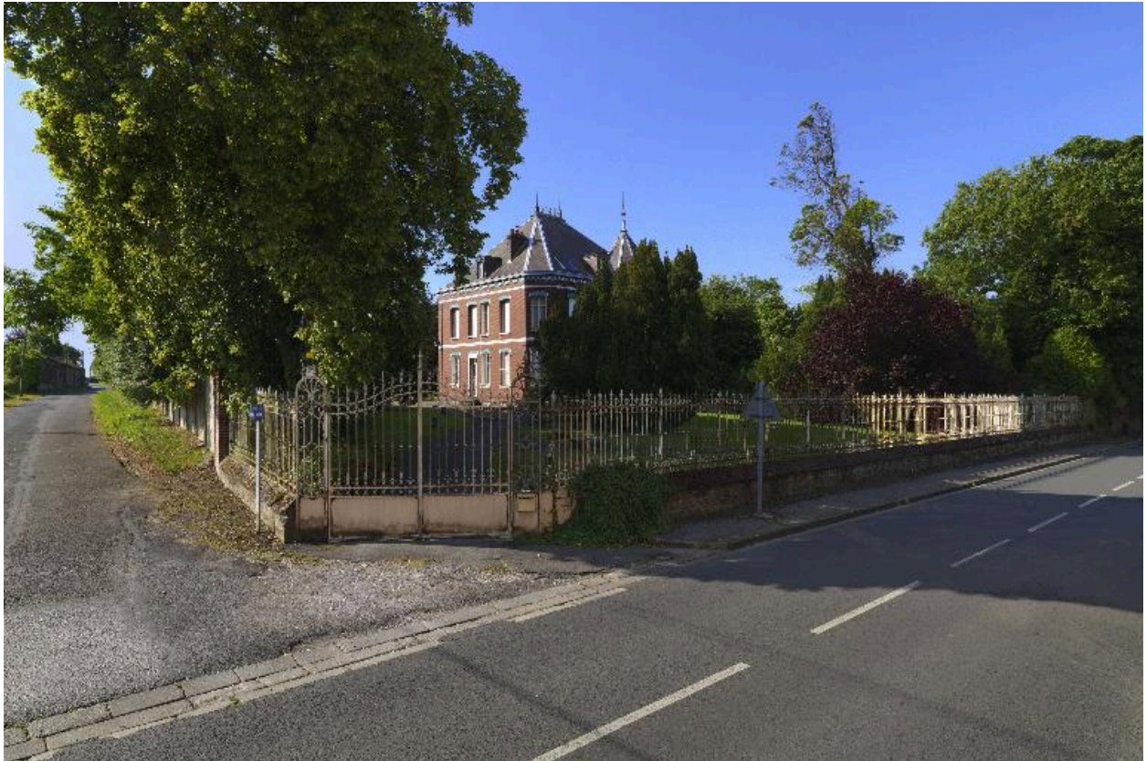
Vue de trois-quarts depuis la rue Jean-Catelas.
