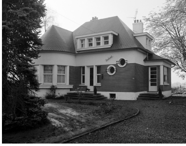
Vue générale, 218 rue Richon. Phot. Philippe Dapvril IVR31_20045900641X
