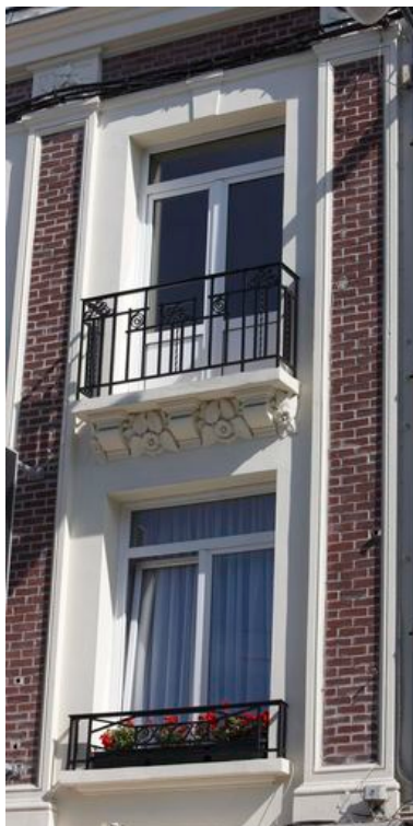
Motifs décoratifs floraux et géométriques des balcons et de leur console. Phot. Pierre Thibaut IVR31_20096200240NUCA
