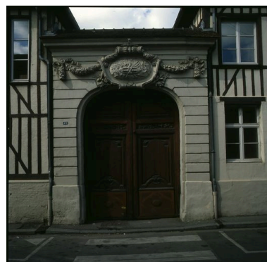
Vue du portail d'entrée. Phot. Thierry Lefébure IVR22_20056000083XA
