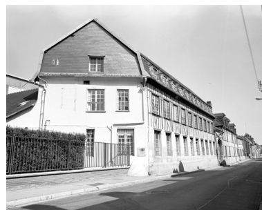
Vue latérale ouest est de la façade sud de la passementerie Gaitas. Phot. Laurent Jumel IVR22_19966002579X
