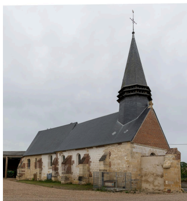
Vue depuis le nord-ouest. Phot. Marc Kérignard IVR32_20226000933NUCA
