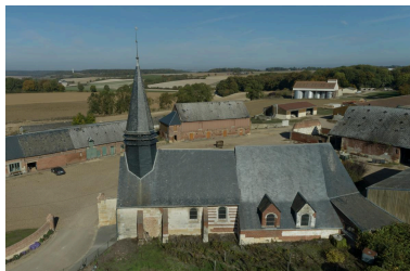
Vue aérienne de l'élévation sud. Phot. Marc Kérignard IVR32_20226001096NUCA
