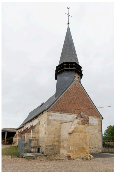
Vue depuis l'ouest. Phot. Marc Kérignard IVR32_20226000932NUCA
