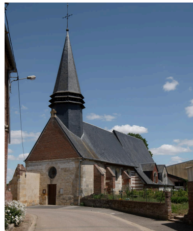
Vue générale depuis le sud-ouest. Phot. Marc Kérignard IVR32_20226000678NUCA
